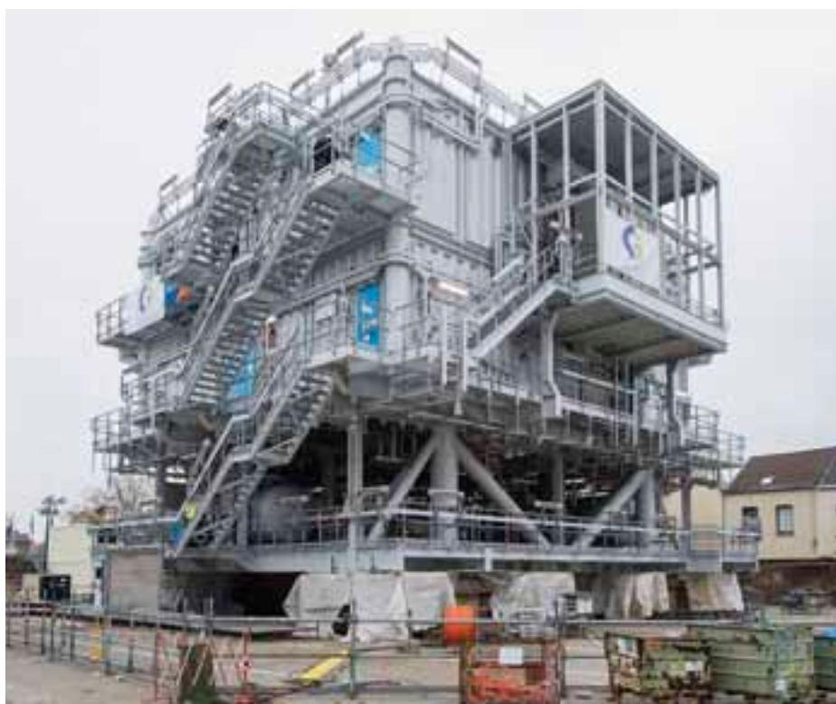
Offshore High Voltage Station voor het Luchterduinen-windpark, gebouwd op Cofely Fabricoms OHVS Station-werf in Hoboken.
